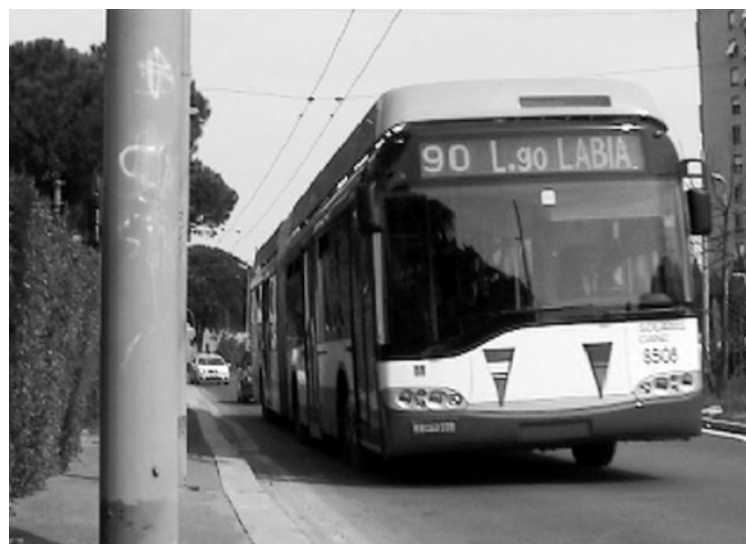
I lavori della linea filobus 90 si sono conclusi. Nonostante le proteste di molti cittadini, i pali installati sul marciapiedi continuano ad ostacolare il transito dei pedoni, sia a piedi che in carrozzina.
